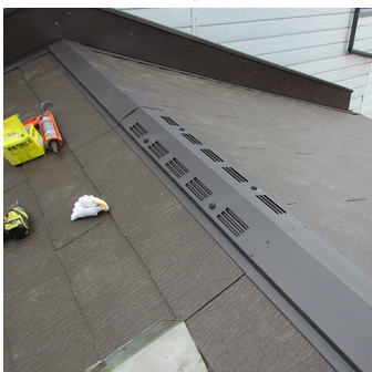
耐震改修工事中
